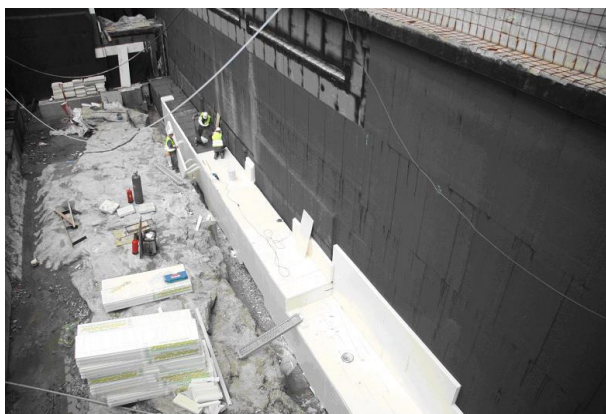
Tätningen skyddas genom isolering
